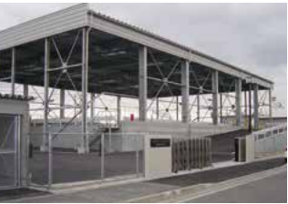
北九州市生态工业园区中心废料研究设施
