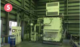
超硬合金リサイクル事業 亜鉛蒸留法とイオン溶解法を原料や状況に応じて選択し、ドリルやチップをはじめとした超硬工具等の原料となる高品位のタングステンカーバイドを回収するなど、幅広い超硬合金リサイクルを行う。 ■事業主体 株式会社株光正
