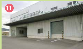
古着リサイクル事業 一般家庭の古着や企業ユニフォームなどの衣料品を受入、自動車用内外装材等の原料にリサイクルする。 ■事業主体 株式会社エヌ・シー・エス ■所在地 若松区向洋町
