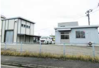
グリーンLPGガス直接合成技術開発実証研究施設 ■研究主体 日本グリーンLPGガス推進協議会
