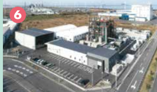
携帯電話リサイクル事業 使用済携帯電話を回収・分別して熱分解処理を行い、プラスチック部分から再生油を製造。残った部分から、金属精錬事業者が金属資源を抽出。また、製造した再生油は熱分解処理の加熱用燃料として使用。 ■事業主体 株式会社JEPLAN
