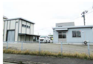
绿色 液化石油气直接合成 技术开发实证研究设施
