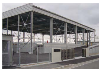
北九州市 エコタウンセンター 廃棄物研究施設
