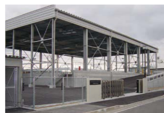
기타큐슈시 에코타운 센터 폐기물 연구시설
